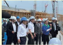
万博会場の大屋根「リング」から会場の全貌を確認する関西広域連合の三日月滋賀県知事(中央左)や西村大阪府知事(中央右)
